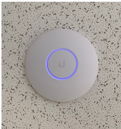
Annexe 16 : Montage terminé
